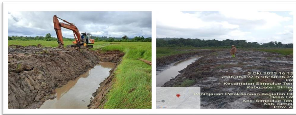
Gambar 19. Normalisasi saluran pada Konstruksi Optimasi Lahan Rawa TA 2023 di Provinsi Aceh
